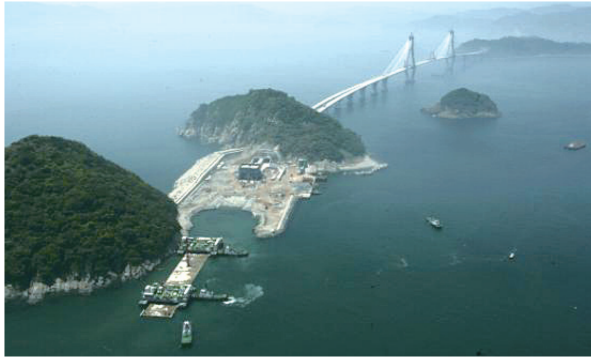
거가대교 침매터널 연결 부산과 거제도를 잇는 총 8.2km길이의 거가대교 침매터널이 13일 개통됐다. 침매터널은 부산 가덕도~대축도 사이 3.7km 구간에서 건설됐으며, 나머지 구간은 섬을 잇는 사장교 2개로 연결됐다. 공사를 맡는 대우건설의 서종욱 사장은 "가장 깊은 곳의 침매는 해저 48m 위치해 있다"며 "일본 네덜란드 전문가들도 불가능하다고 한 것을 대우건설 기술로 해결했다"고 밝혔다. [사진=대우건설 제공]
