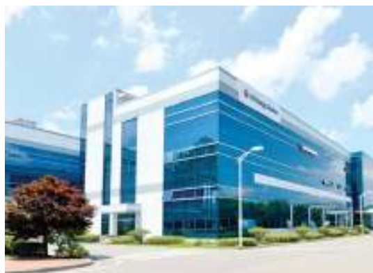
LG에너지솔루션 오창 에너지플랜트 전경. 사진제공 LG에너지솔루션
