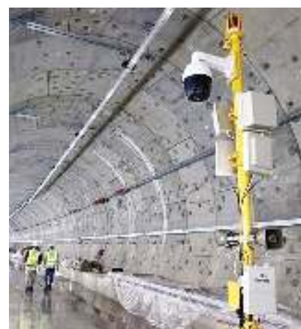
터널 공사 현장에 설치된 HITTS 장비.
