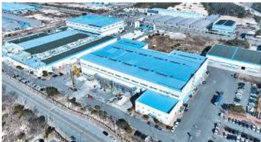
포스코실리콘솔루션이 19일 포항 영일만 산업단지에 실리콘음극재 공장을 준공했다. 사진제공 포스코실리콘솔루션
