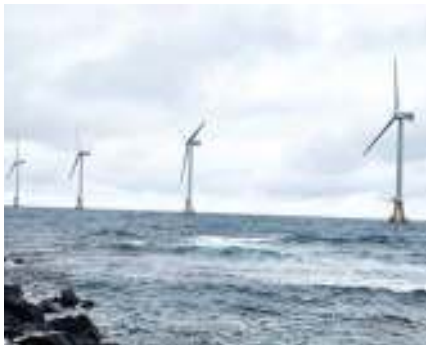
제주시 환경면 두모리·금등리의 탐라해상풍력발전단지 모습.
