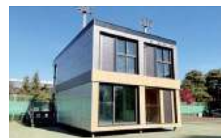
GS건설 용인기술연구소에 설치된 철골모듈러 목업(Mock-up). 사진제공 GS건설
