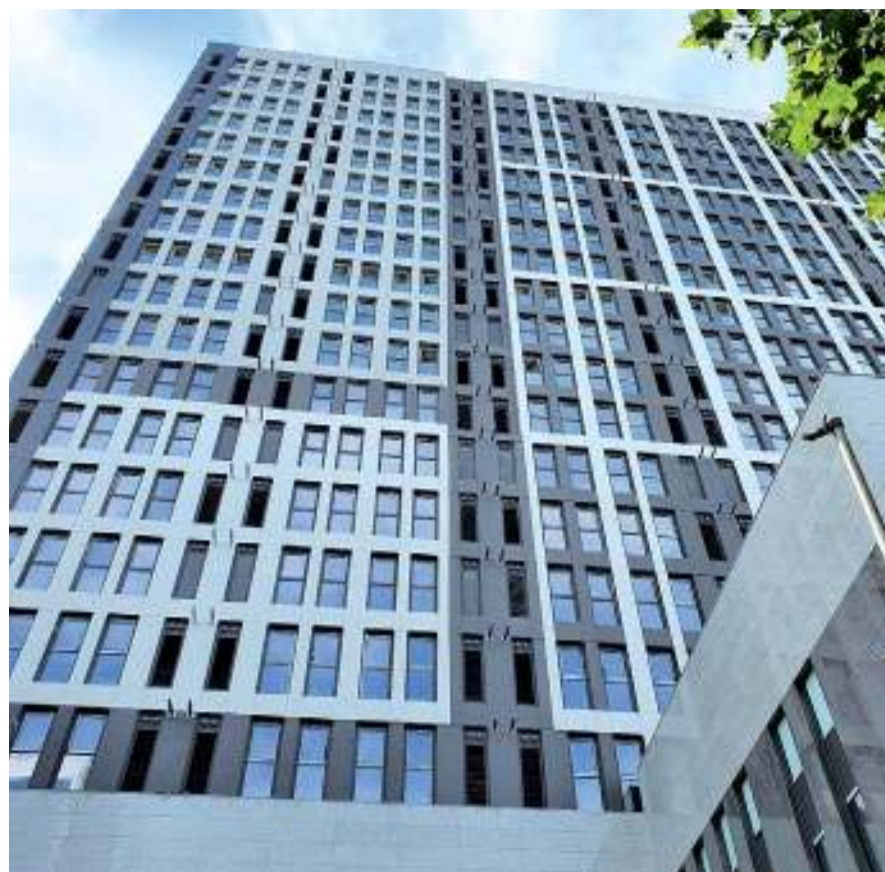
서울 영등포구 당산동 인근에 공사중인 역세권 청년주택 모습. 과밀개발로 주거환경이 열악해질 수 있다는 우려가 나오고 있다.
