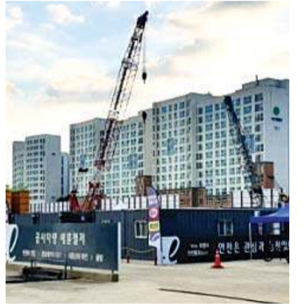
서울 강서구 마곡 마이스 복합개발사업 공사현장.
