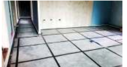
고성능 완충재 시공 모습. 사진제공 현대건설
