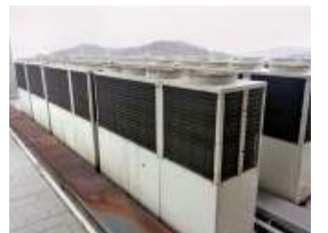
건물 옥상에 설치된 엔진구동식(GHP) 가스냉방기. 사진제공 한국가스공사
