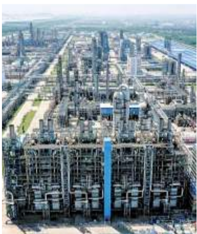
중국이 완료된 중한석화의 에틸렌 설비.
