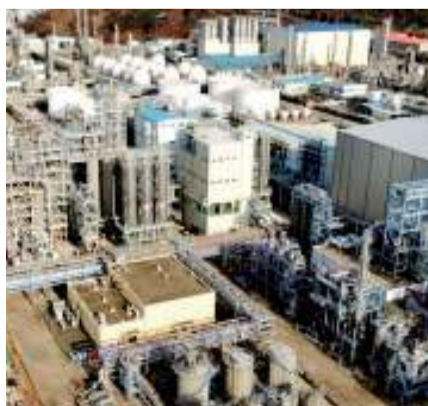
전남 여수 DL케미칼 폴리 에틸렌 공장 전경.
