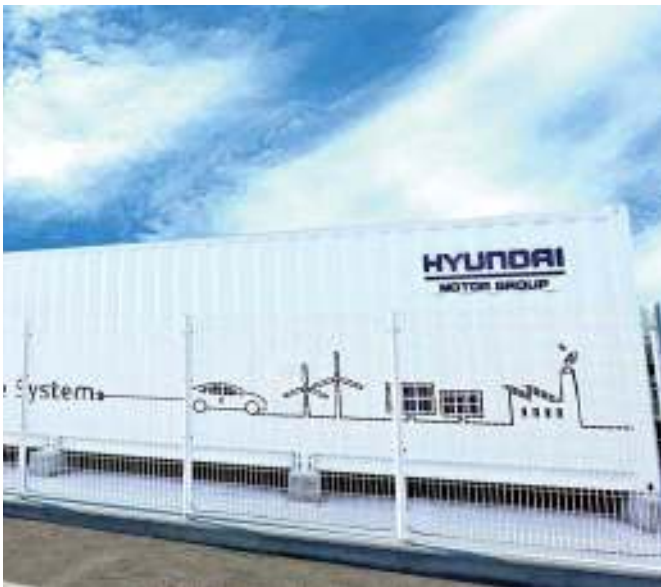
현대차 울산 공장(왼쪽)과 OCI스페셜티 공주 공장 내 태양광 발전소에 설치한 전기차 배터리를 활용한 에너지 저장장치(ESS).
