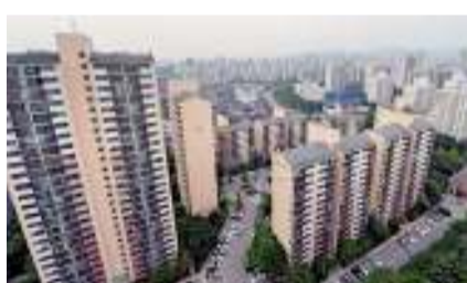
성남시 분당구 정자동 느티마을 3·4단지 전경. 이투데이 DB
