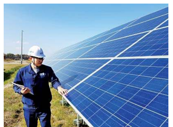
LS산전 관계자가 28MW급 일본 치토세 태양광 발전소 모듈을 점검하고 있다. 사진제공 LS산전
