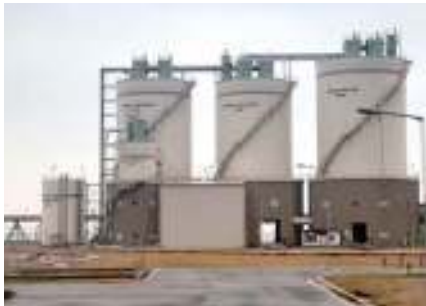
비디아이가 납품한 영흥화력발전소 화처리시설.
