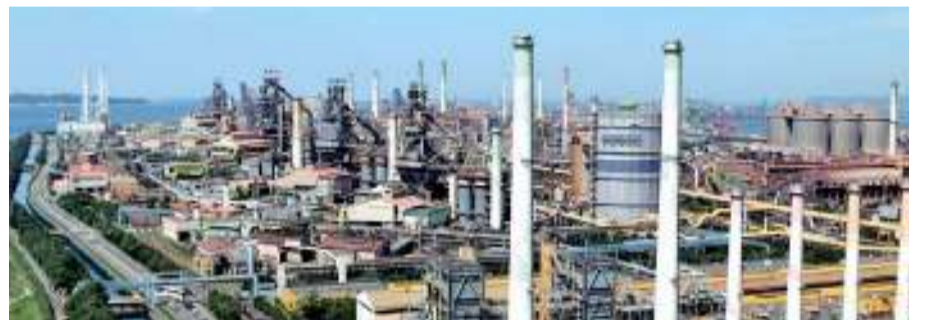
포스코는 매년 설비투자 전체 예산의 10%를 환경개선에 투자, 미세먼지 배출 저감에 적극 나서고 있다. 사진은 포항제철소 전경. 사진제공 포스코
