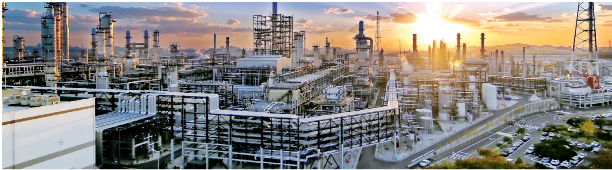
인천광역시 서구에 위치한 SK인천석유화학 공장 전경. SK인천석유화학은 50만 평 규모의 공장설비를 갖추고 있다.
