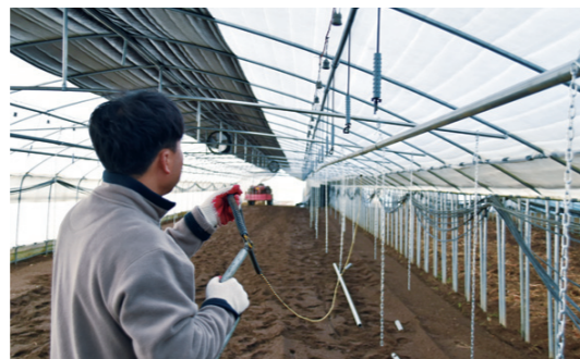
작년 11월 춘천시 남산면 광판리에 위치한 화훼농가 농장주가 비닐하우스에 탄소섬유 발열케이블을 설치하고 있다. 사진제공 전북창조경제혁신센터
