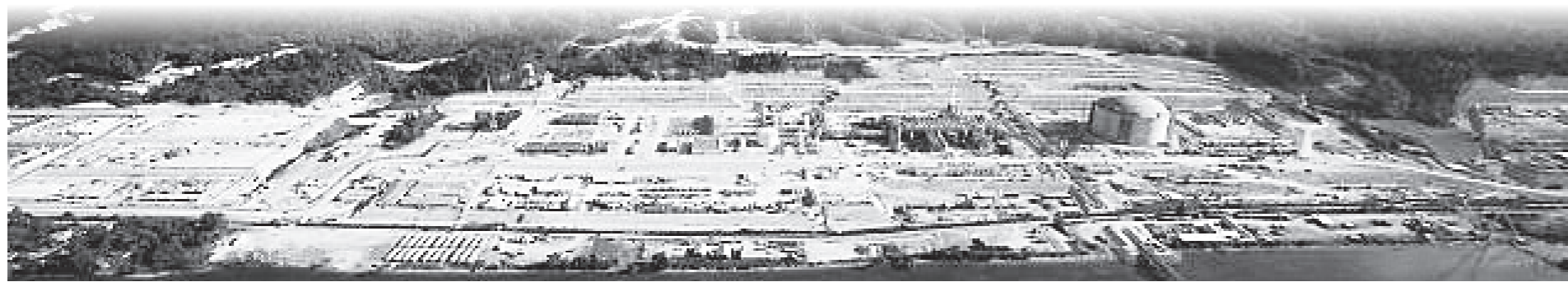
가스공사가 일본 미쓰비시상사, 인도네시아 에너지 공기업인 페르타미나와 함께 인도네시아 북부 술라웨시섬 동부 해안에 천연가스 액화 플랜트를 건설해 LNG를 생산·판매하는 투자개발형 사업인 동기 세노로 LNG 시설 전경.
