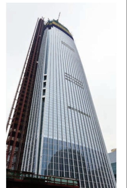
막바지 공사 중인 제2롯데월드. 뉴스시스
