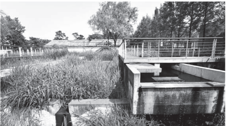
옛 정수장 약품 침전지의 구조물을 이용해 만든 수질 정화원. 이곳에서는 수생식물들의 물속 질소, 인 등 오염물질의 정화과정을 볼 수 있다.
