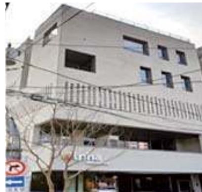
서울 강남구 소재 알파빌딩에 ‘건물 일체형 태양광 발전 패널’ 설치 전(사진 왼쪽)·후(오른쪽).
