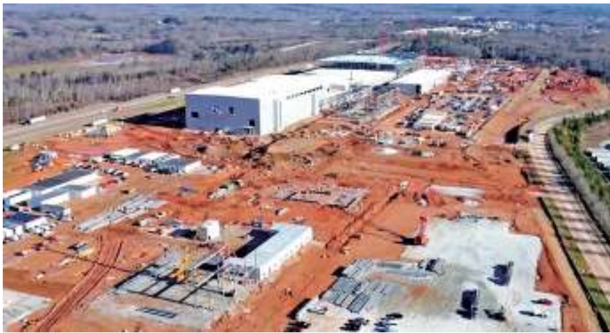
SK이노베이션이 미국 조지아주 잭슨 카운티에 건설 중인 전기차 배터리 공장.
