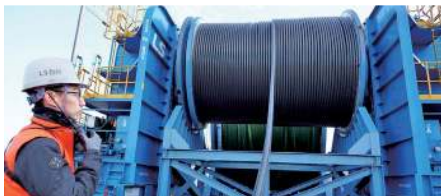
LS전선 직원이 북당진-고덕 구간 고압직류송전(HVDC)케이블을 점검하고 있다. 사진제공 LS전선
