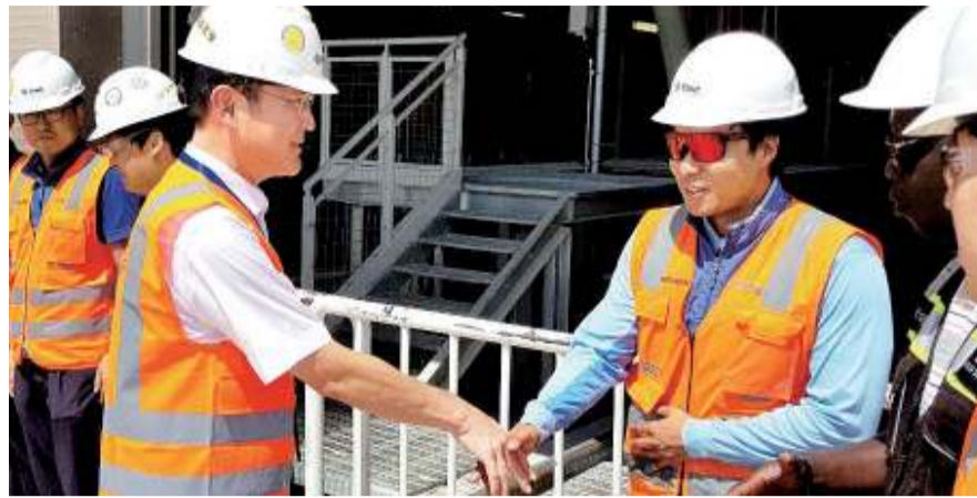
이재용(왼쪽) 삼성전자 부회장이 15일 삼성물산이 건설 중인 사우디아라비아 리야드 도심 지하철 공사 현장을 방문해 현지 임직원들을 격려하고 있다. 사진제공 삼성전자
