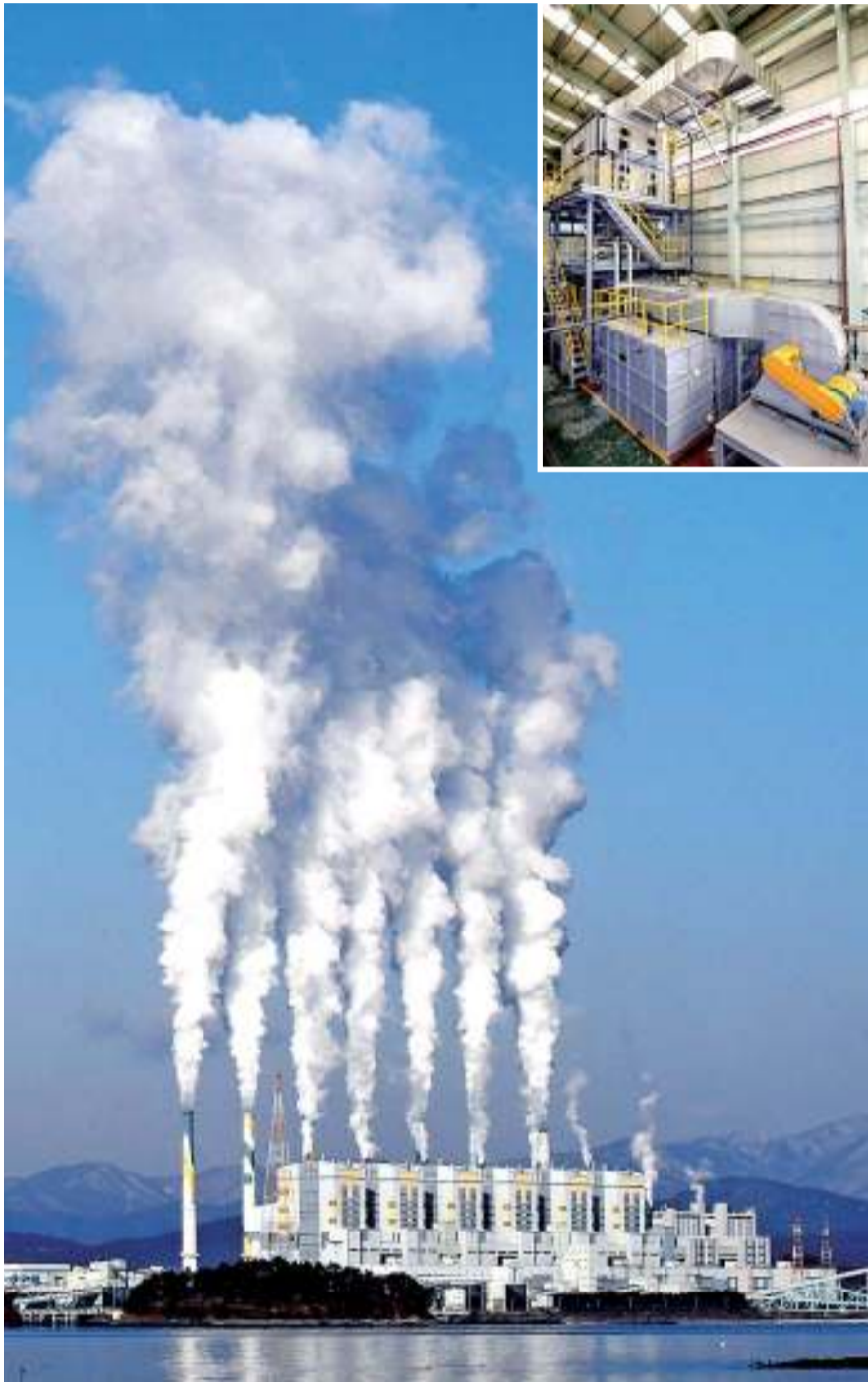
2월 1일 경남 하동군 하동화력발전소 굴뚝에서 뿜어 내는 연기가 뿜어져 나오고 있다. 오른쪽 위 사진은 경남 창원 두산중공업 본사에 설치된 석탄화력발전소용 파일럿 EME. 정전기를 이용해 화력발전소에서 나오는 연기와 미세먼지를 한번에 잡는 설비다.
