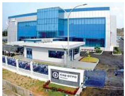
인도네시아 합작법인 'CKD-OTTO' 항암제 생산 공장 전경.
