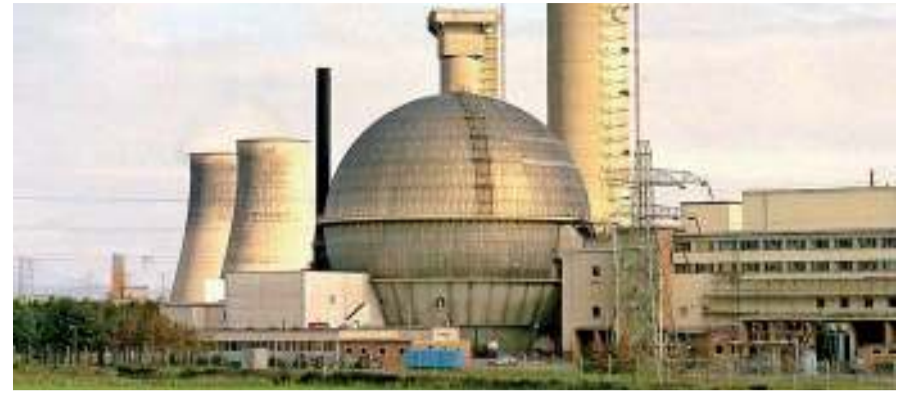
영국 원전의 70%가 위치한 셀라필드 원전산업단지 전경.
