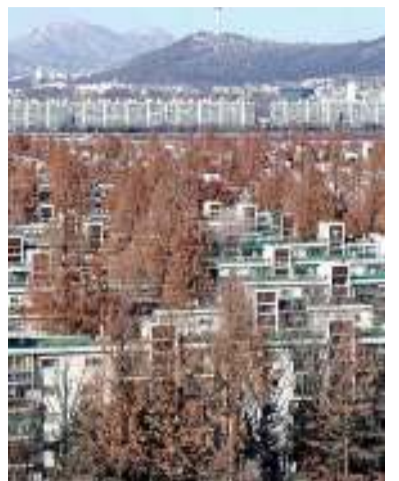
반포주공1단지 3주구 아파트 전경.
